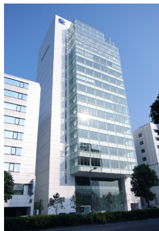
ワールド北青山ビル
